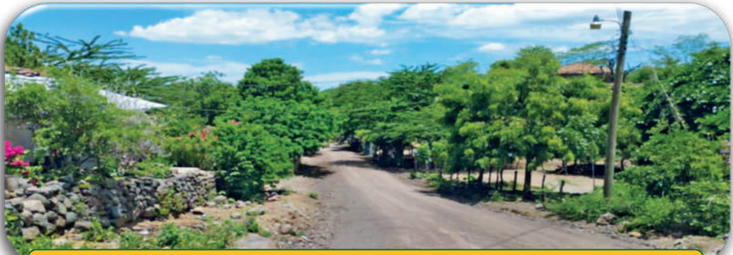
Reparación de tramo de carretera desde el Caserío El Quebracho, Pespire, Choluteca hacia el Caserío Portillo Blanco, Soledad, El Paraíso.
