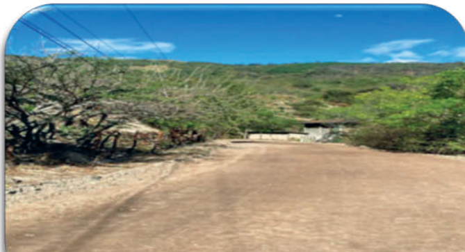
Se Reparó 10.8 Km de la carretera La Palma, San Juan Bosco y San Jorge.
