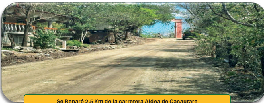
Se Reparó 2.5 Km de la carretera Aldea de Cacautare
