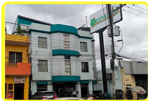
Oficina Centenario 6ta y 7ma Ave., 9na calle Tels.: 2238-4990, 2237-9444, 2237-3040
