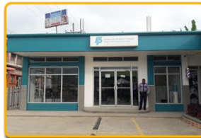
Oficina Morazán Yoro Barrio san José, Calle Principal Tels.: 2691-0111- 2691-0112
