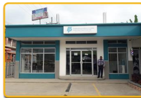
Oficina Morazán Yoro Barrio san José, Calle Principal Tels.: 2691-0111- 2691-0112
