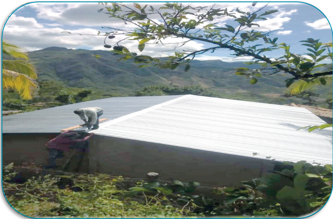
Compra de materiales para reparación de paredes, piso, techo e instalaciones eléctricas a la Escuela Simón Bolívar de la comunidad de Las Marías, aldea El Guayabo, Pespire
